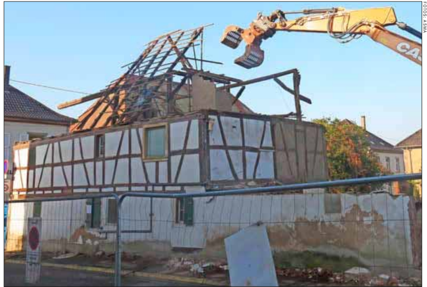
Das Haus Greder in Geudertheim, Baujahr 1662, wurde letztes Jahr abgerissen.
