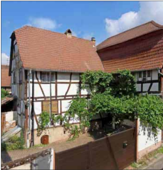
Das Haus Riff in Brumath wurde vor dem Abriss gerettet.
