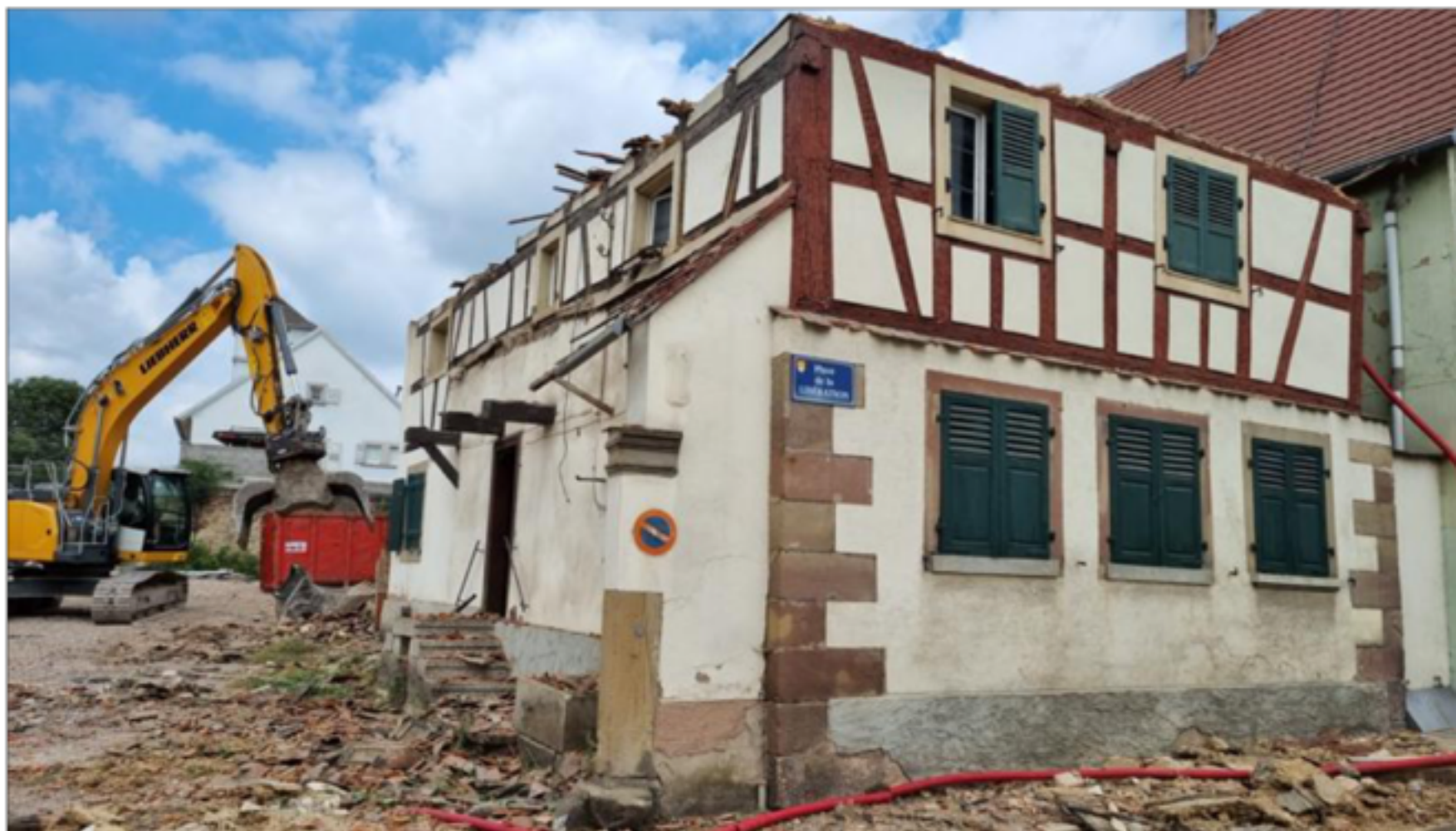
La maison alsacienne du XIX e siècle, place de la Libération à Hochfelden, a été démolie ce mercredi matin 27 juillet. Photo DNA/S.G.
